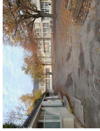
Ecole Lesage – Avant travaux
